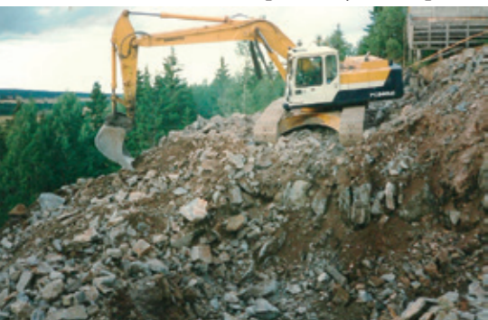
Jyrkässä rinteessä työskentely vaati rohkeutta kaivinkonekuskilta Markku Isomäeltä.
